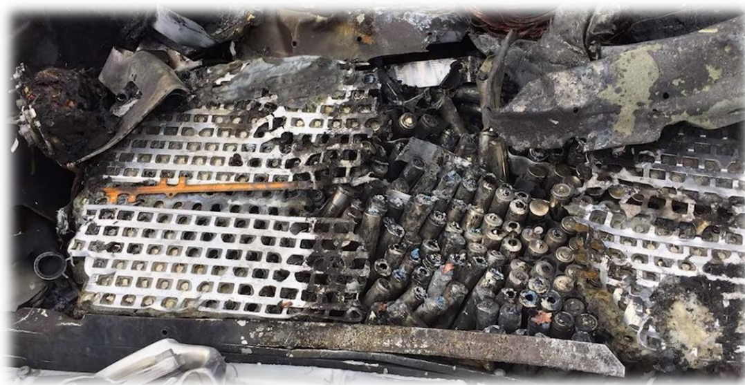
Obrázek 24 - Články baterie po požáru (6)
