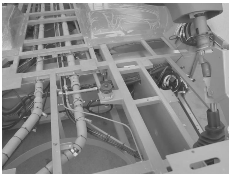
Obrázek 18: Kabely a trubky v roštu podvozku
