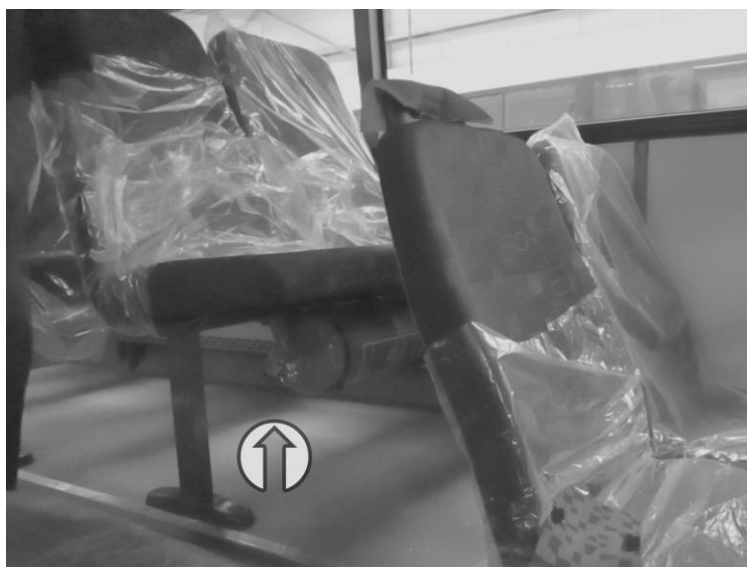
Obrázek 73: Ruční hasící přístroj upevněný pod sedákem cestujících
