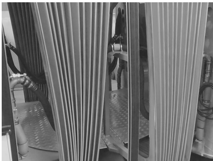
Obrázek 45: Prostor mezi díly kloubového autobusu s odhaleným měchem. V mezeře je vidět zesilující přepážka a spojovací vedení a kabely
