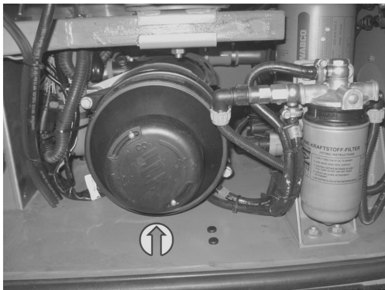
Obrázek 49: Nezávislé topení v předposlední schráně vpravo uložené pod akumulátory
