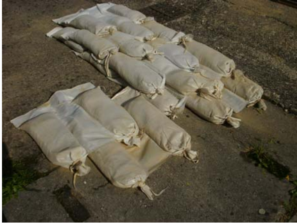
Umístění hráze z dvoukomorových pytlů
