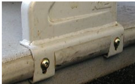
Obr. 57 uchycení boční (možnost posouvání)
