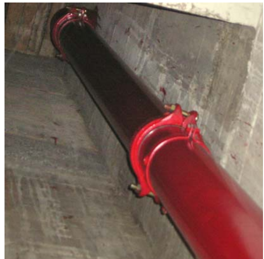
Obr. 18: Plnicí potrubí SHZ vedené vnitřkem objektu.
