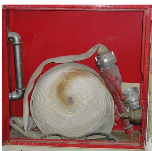
Obr.23: Skříň suchovodu.
