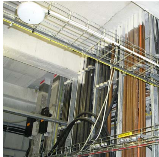
Obr. 2: Prostupy rozvodů elektrické energie stropem ve výškové budově.
