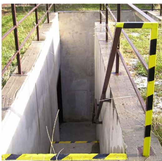
Obr. 15: Vstup do strojovny SHZ z vnějšku objektu.
