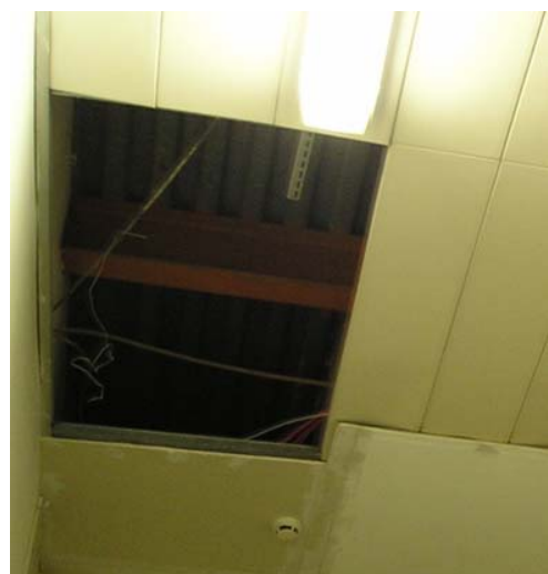
Obr. 4: Podhledy ve kterém jsou vedeny rozvody elektrické energie a dat
