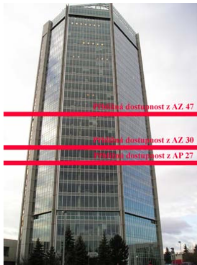
Obr. 1: Orientační úrovně dostupnosti výškové techniky při zásahu ve výškové budově
