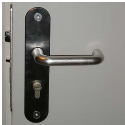
Obr. 45: Bezpečnostní kování na druhé straně dveří.
