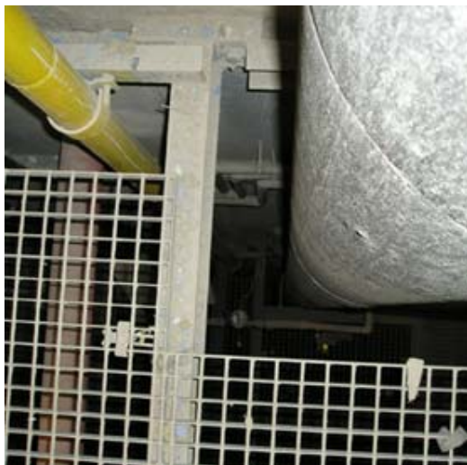
Obr. 3: Instalační šachta rozvodů plynu a vody prochází celou výškou objektu
