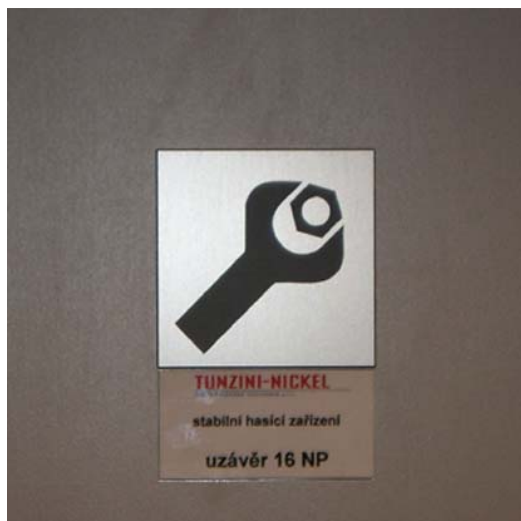
Obr. 5: Uzávěr SHZ. Uzávěry pro příslušné patro jsou obvykle umístěny o patro níž.
