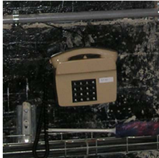
Obr.37: S obsluhou SHZ je možné komunikovat prostřednictvím vnitřního telefonu.
