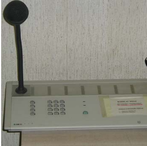
Obr.36: S osobami v objektu může velitel zásahu jednosměrně komunikovat prostřednictvím rozhlasu.
