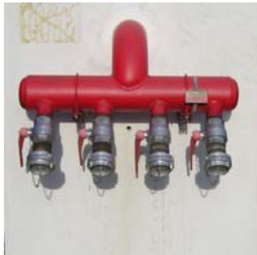
Obr. 10: Plnicí místo pro plnění nádrže SHZ
