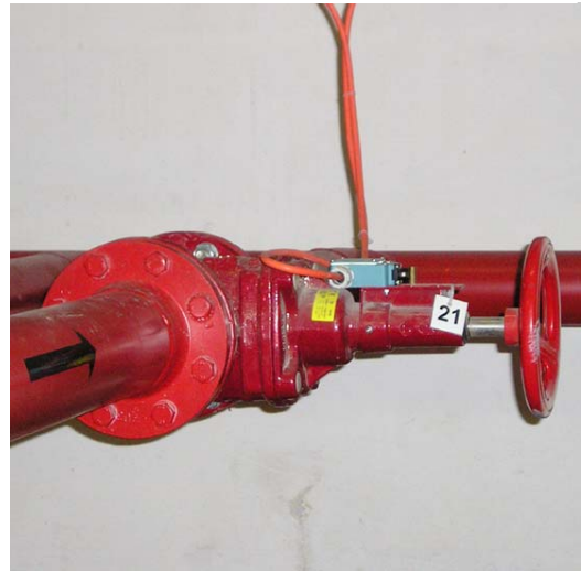
Obr. 18: Plnicí potrubí SHZ vedené vnitřkem objektu.
