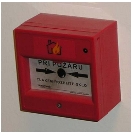
Obr. 28: Tlačítkový hlásič požáru.
