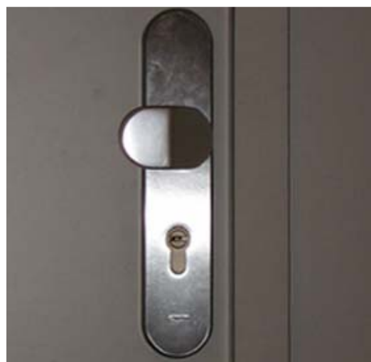
Obr. 44: Bezpečnostní kování může ztížit zásahu. Vhodné je vybavit zasahující hasiče universálním klíčem.
