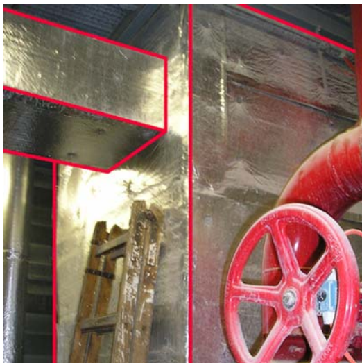
Obr.27: Značení rozvodu VZT uvádí směr proudě, funkci rozvodu a dotčenou sekci.
