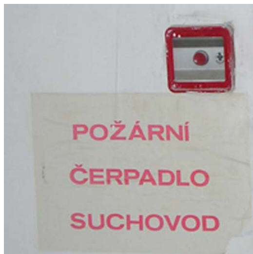
Obr.22: Ovládací tlačítko suchovodu umístěné na ChÚC.
