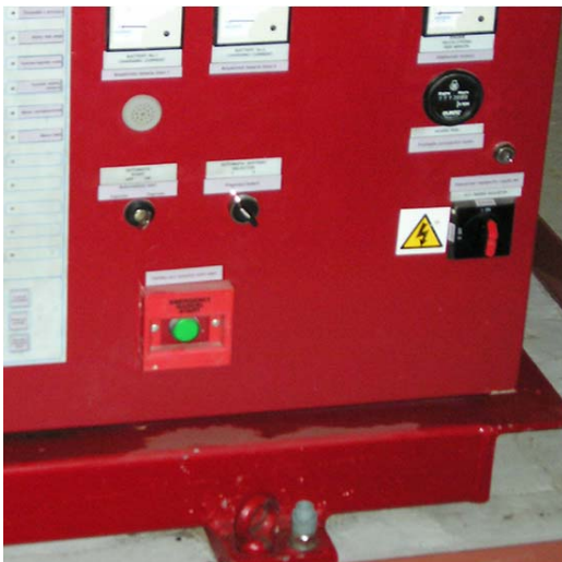
Obr. 13: Ruční startér záložního čerpadla SHZ na diesellový pohon.
