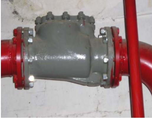
Obr. 11: Klapka na potrubí SHZ nedovolí kapalině proudit opačným směrem. Doplnit techniku z nádrže SHZ nelze.
