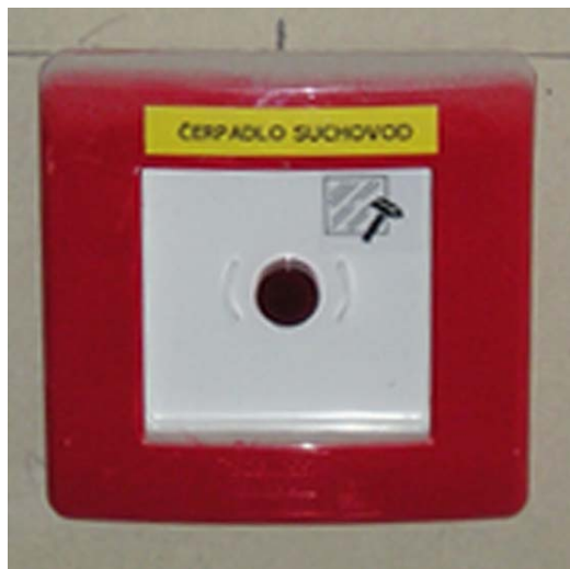
Obr.21: Ovládací tlačítko suchovodu spustí posilovací stanice suchovodu. Je umístěno obvykle na ChÚC a musí být funkční
