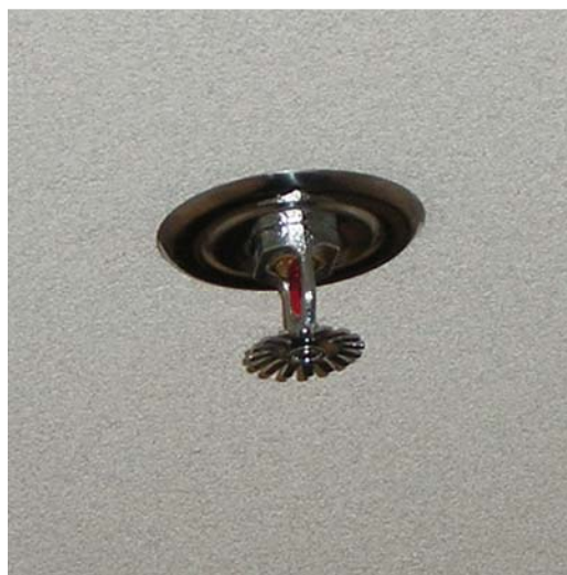
Obr. 6: Sprinklerová hlavice. Červená ampule uvádí reakční teplotu sprinkleru 60 °C.
