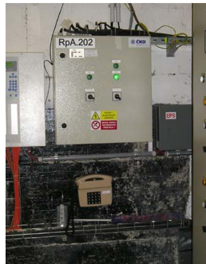
Obr. 10: Plnicí místo pro plnění nádrže SHZ
