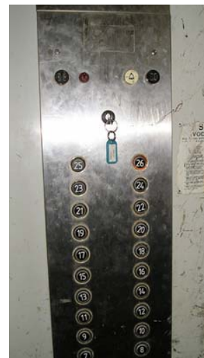
Obr.34: Ovládací panel požárního výtahu. Pro zásah je výtah použitelné po jeho „odemčení“ klíčem.
