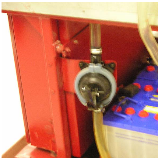
Obr. 9: Ruční palivová pumpa záložního dieslového čerpadla SHZ
