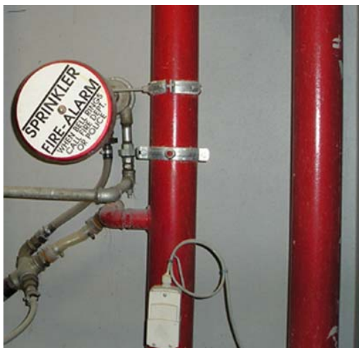
Obr. 17: Zvuk zvonu SHZ signalizuje, že potrubím proudí voda a zařízení je v chodu. Zvonník je na každém podlaží v objektu.
