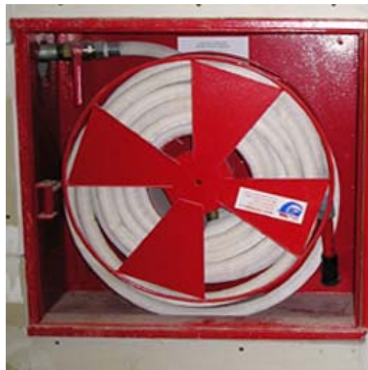
Obr. 24: Skříň hydrantu vybavená tvarově stálou hadicí D 21.
