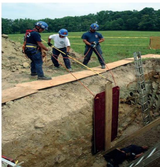
Obrázek 27, Spouštění bednicí desky do výkopu pomocí trámů [1]
