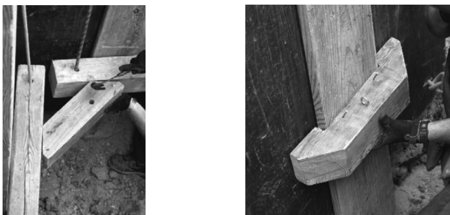
Obrázek 10, Nasazení dřevěných prvků při stabilizaci rohových výkopů [6]
