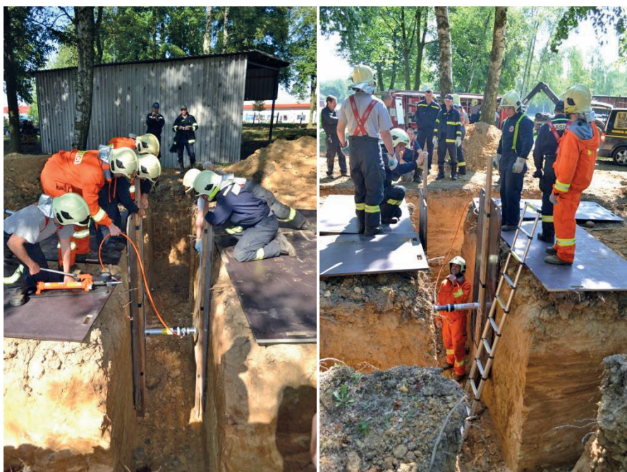
Obrázek 32, Určení délky a správné nasazení středové stabilizační tyče bez nutnosti vstupu do výkopu [5]
