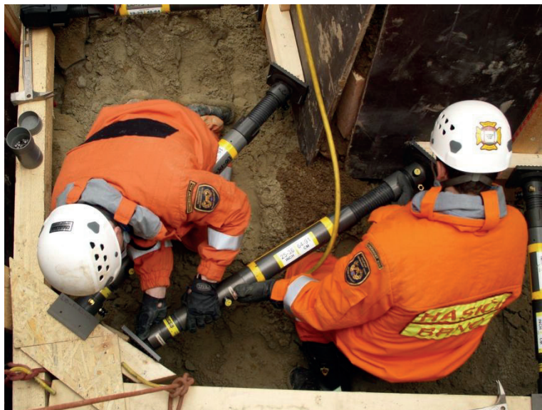
Obrázek 58, Umístění šikmých tyčí v rohovém výkopu [5]
