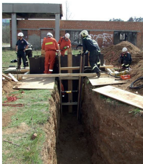
Obrázek 131, Ukázka možnosti doplnění utrženého vnitřního rohu pomocí nízkotlakých vaků a celkové pohledy na situaci [5]
