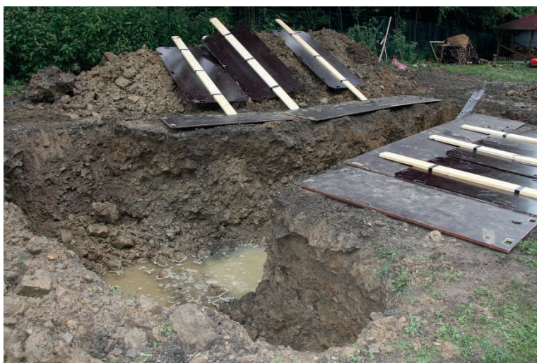
Obrázek 6, Přítomnost vody ve výkopu [5]
