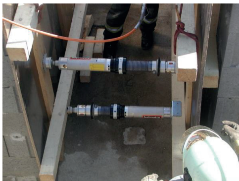
Obrázek 33, Nasazení středové stabilizační tyče do bednicí desky [5]
