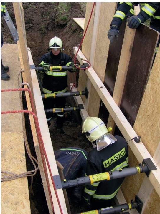
Obrázek 43, Nasazení vnitřních trámů zajišťuje možnost hlubokého kopání [5]
