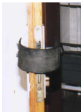
Obrázek 40 Prostor ve kterém je prováděn průzkum (dveře se nemohou zaklapnout)
